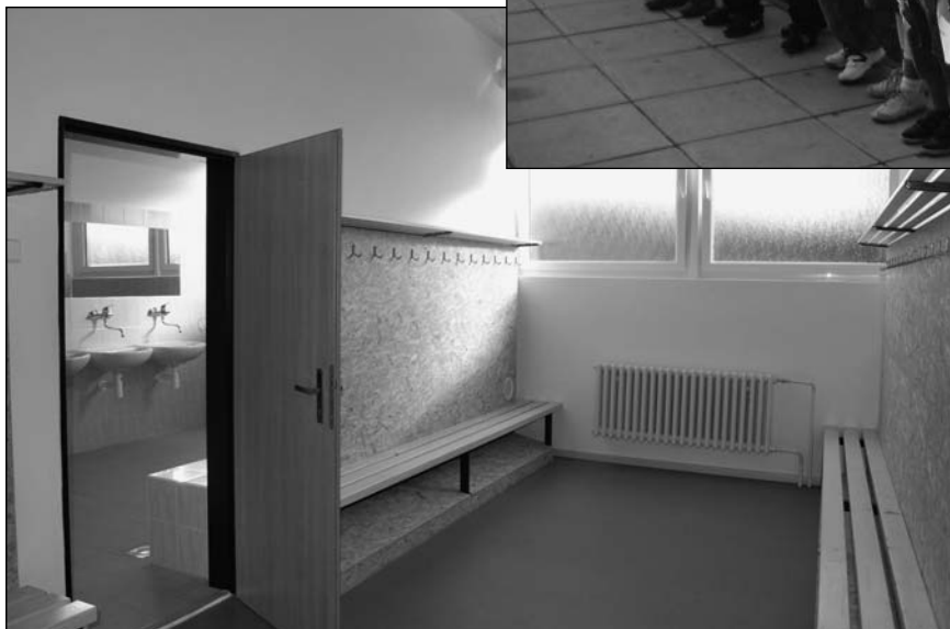
Rekonstruované šatny a sprchy u haly BIOS
